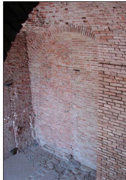
Il fornice a nord tamponato
