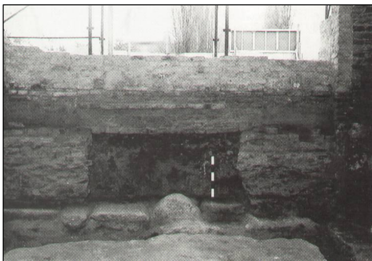
Arco sud: fase di asportazione della tamponatura e soglia originaria
