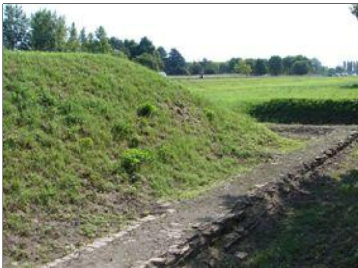
Rivellino ricostruito nel rispetto degli ingombri originali
