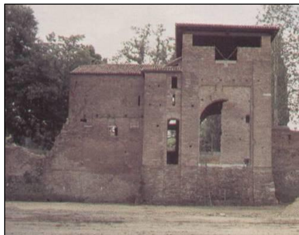
Il fornice maggiore aperto a metà durante il restauro, ora nuovamente tamponato
