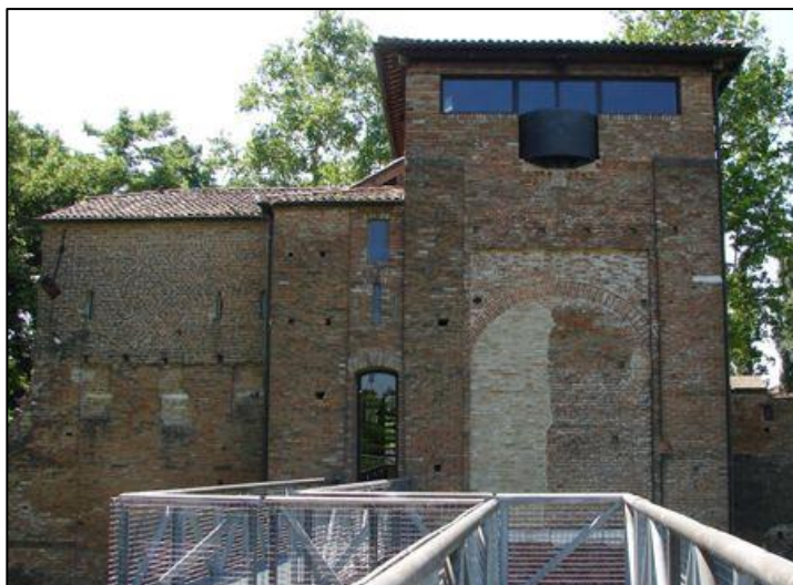
Il fornice maggiore aperto a metà durante il restauro, ora nuovamente tamponato
