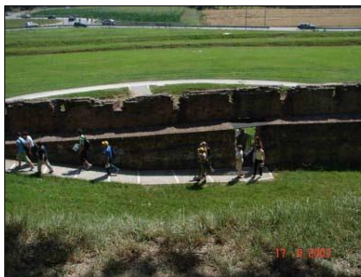
Vallo interno con camminamento di ronda
