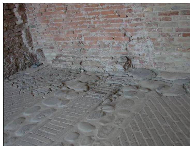
Arco nord: pavimentazione cinquecentesca e integrazione moderna
